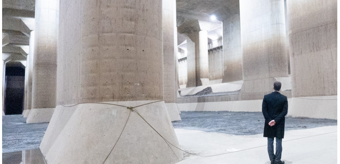
Sistema abrange 6,3 quilômetros de túneis, reservatórios e turbinas.
